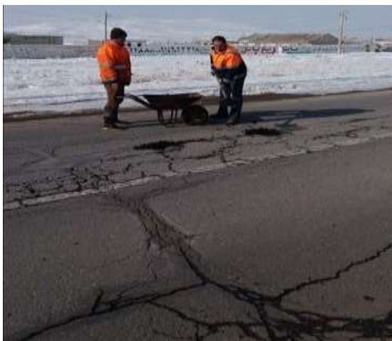
شکل ۵- اثر نمک بر روی آسفالت و سیمان
