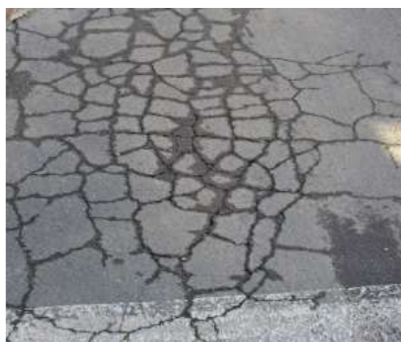
شکل ۵- اثر نمک بر روی آسفالت و سیمان
